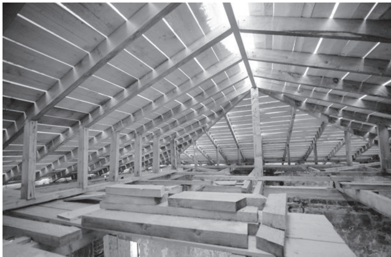
▲ Antifaschismus in luftiger Höhe: Besetzer*innen bauten trotz polizeilicher Repression ein neues Dach für Libertatia. Foto: Leftéris Epanastátis
